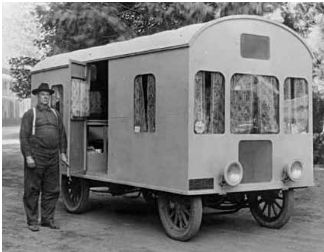
O motorhome R.E. Jeffrey's foi montado sobre o chassis de um Pierce-Arrow 1905
